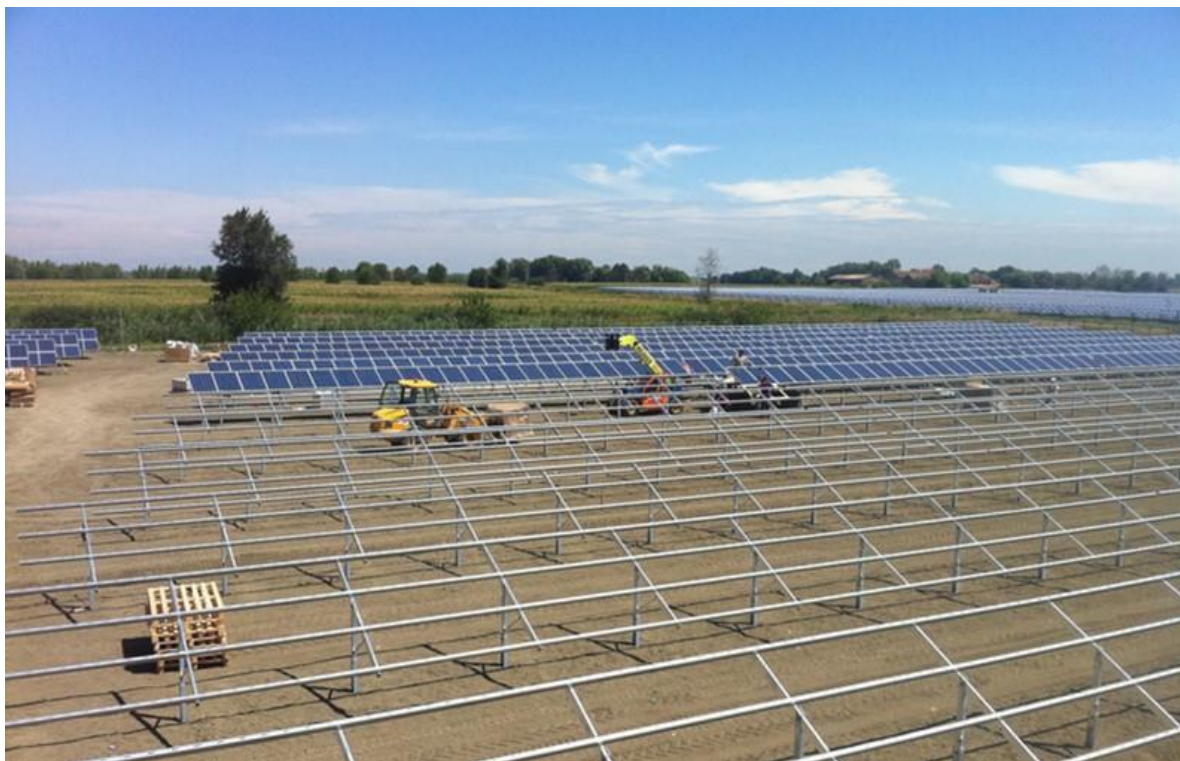
Rysunek 30 Proces montażu modułów fotowoltaicznych na konstrukcji szkieletowej
