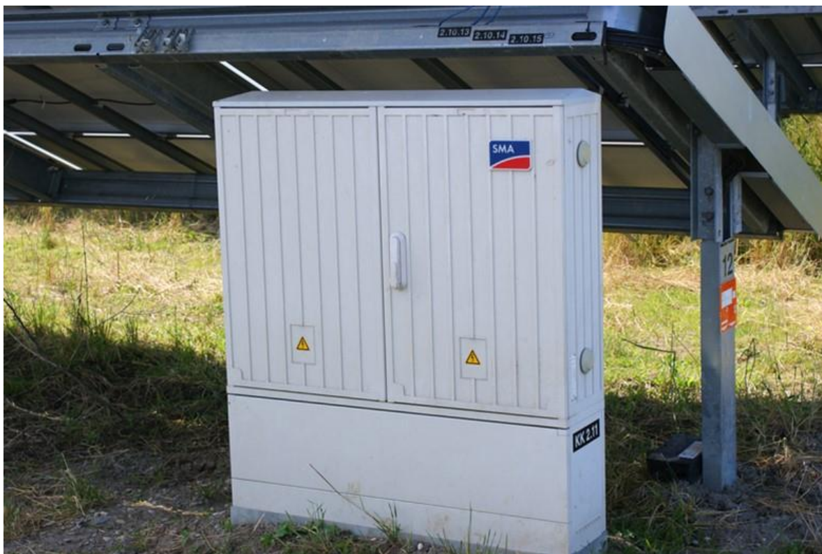
Rysunek 18 String-box mocowany na gruncie
