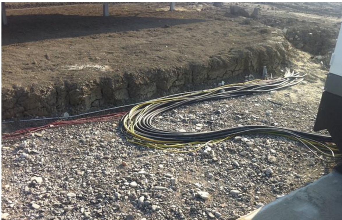
Rysunek 29 Przewody ułożone w wykopie – z prawej strony widoczny fragment płyty fundamentowej oraz sam obiekt inwertera
