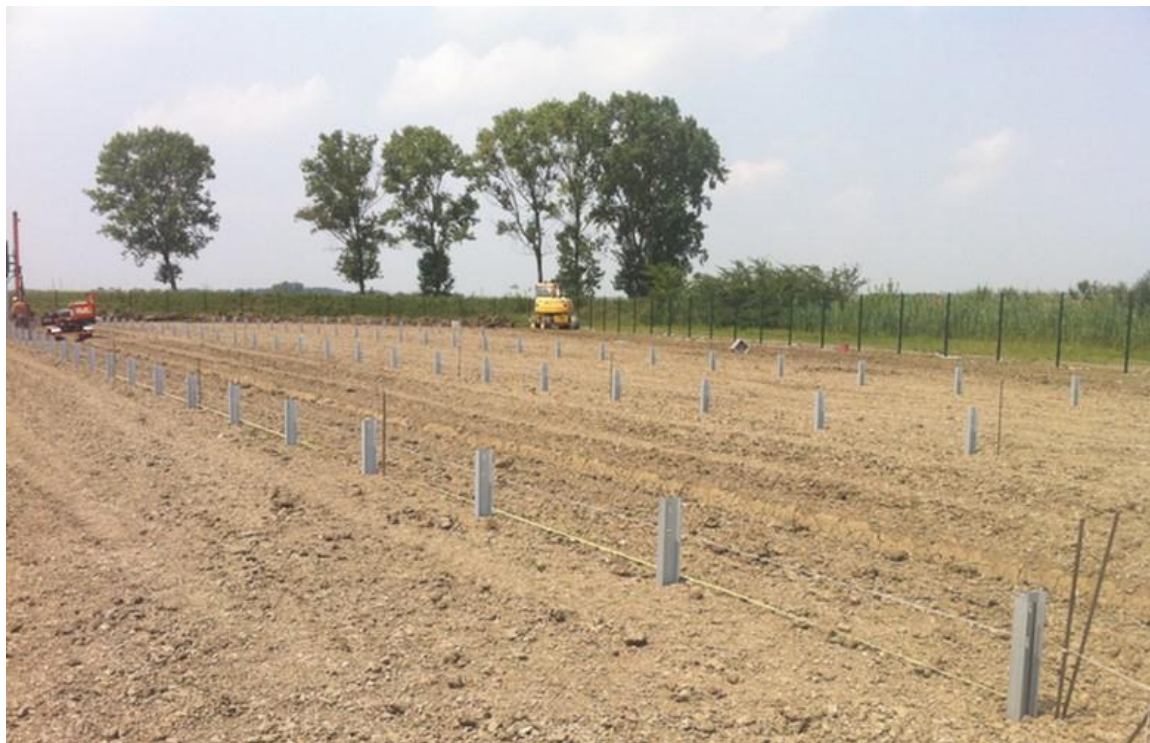
Rysunek 27 Profile nośne wbite w rodzimy grunt
