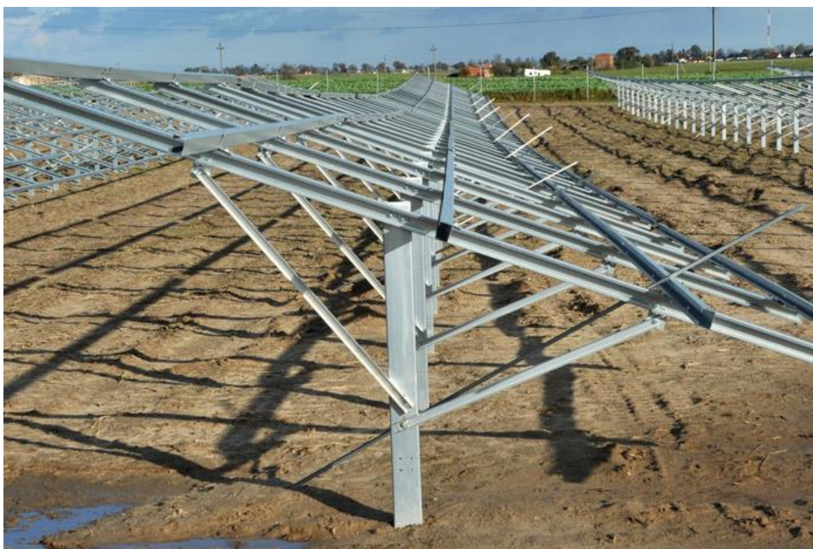
Rysunek 17 Sposób łączenia szkieletu-podstawy modułów fotowoltaicznych z profilami z wykorzystaniem zastrzałów
