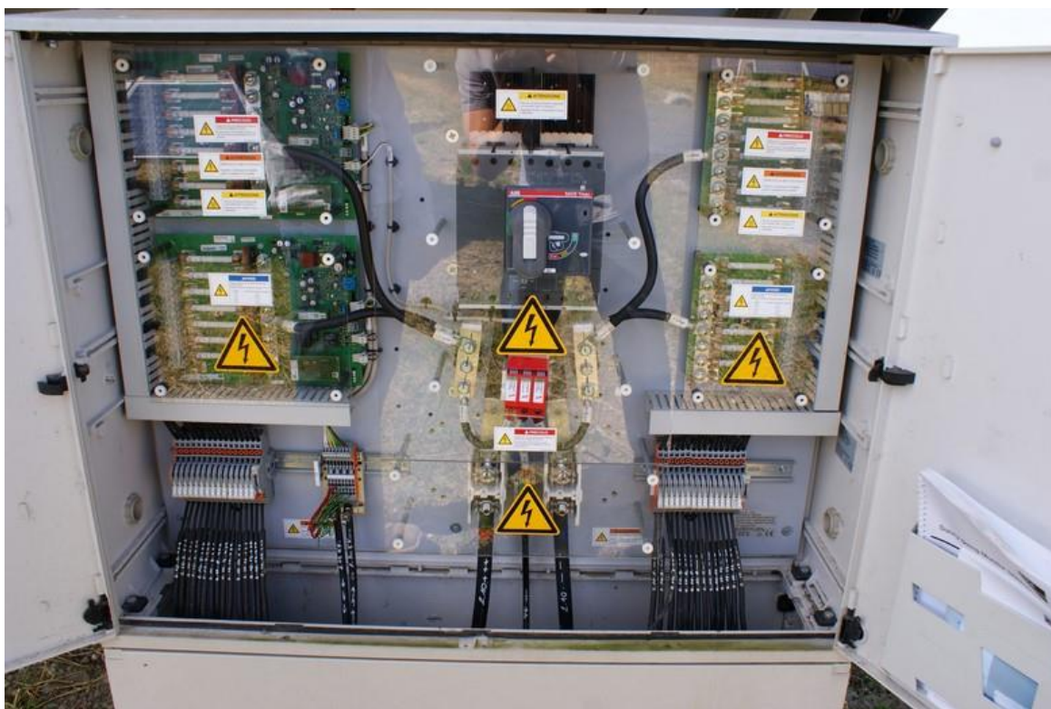
Rysunek 19 Wnętrze string-box`a
