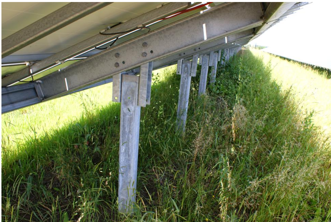
Rysunek 16 Sposób łączenia szkieletu-podstawy modułów fotowoltaicznych z profilami bez zastrzałów
