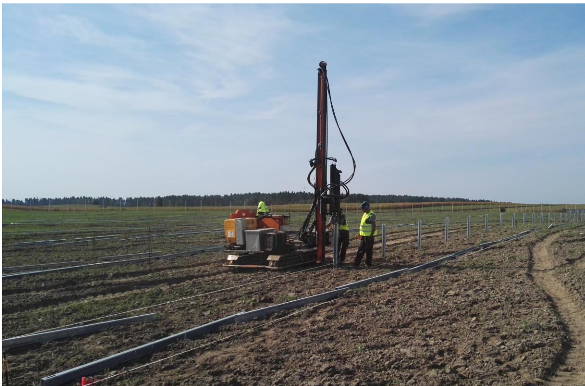
Rysunek 26 Kafar do wbijania profili nośnych
