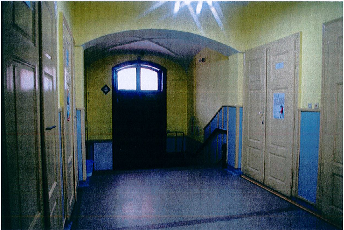
Hall główny na parterze. Widok na drzwi wejściowe.
