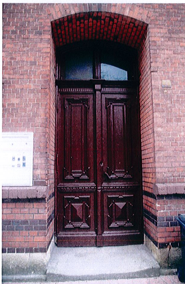
Widok na wejście główne w elewacji frontowej (południowej).
