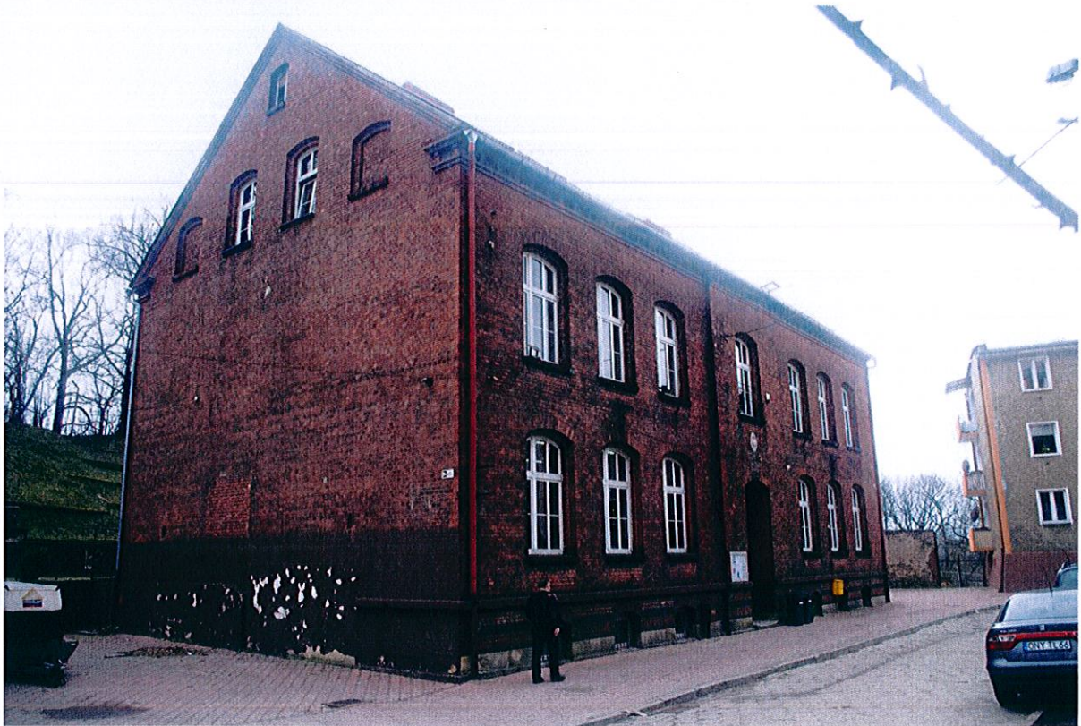
Widok na północno-wschodni narożnik budynku.
