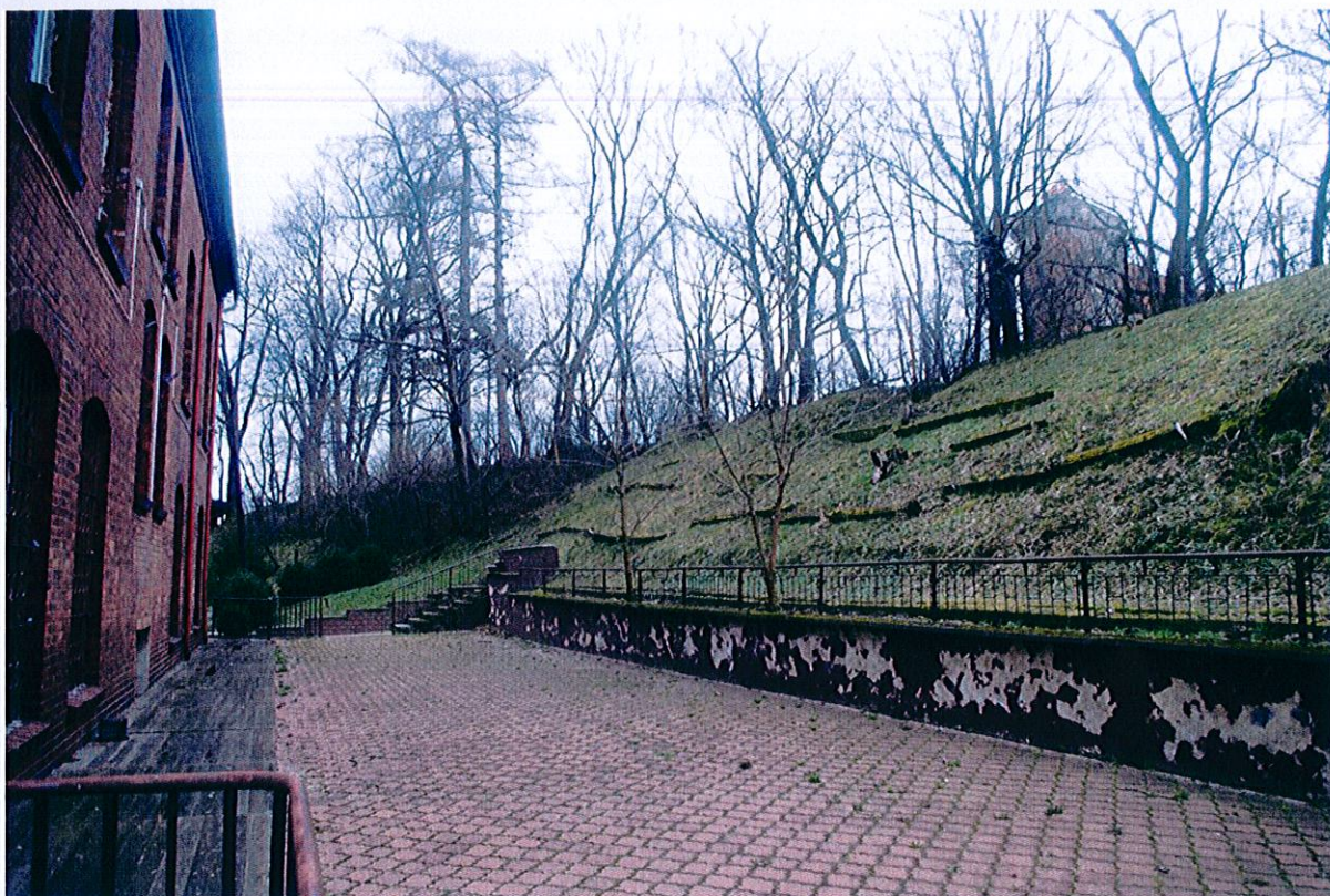
Widok od strony zachodniej na podwyższony taras, skarpgę oraz południową elewację budynku.
