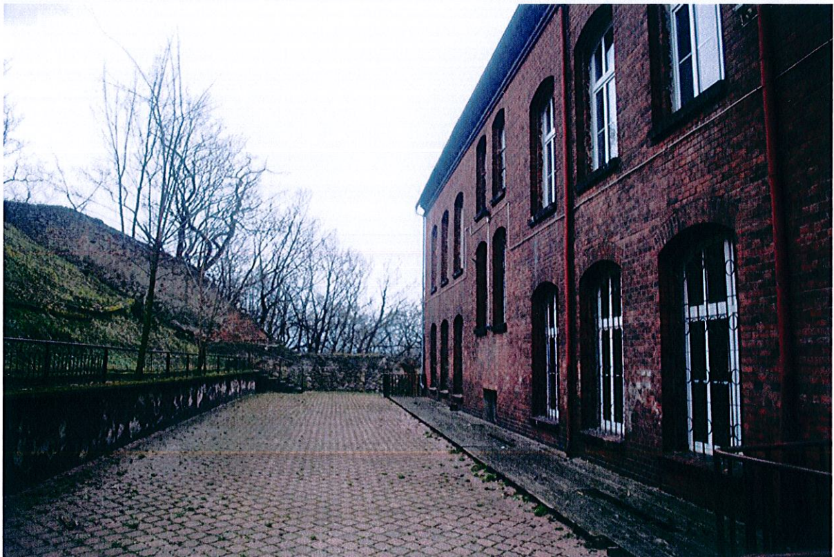
Widok od strony wschodniej na południową elewację budynku, podwyższony taras i skarpię.
