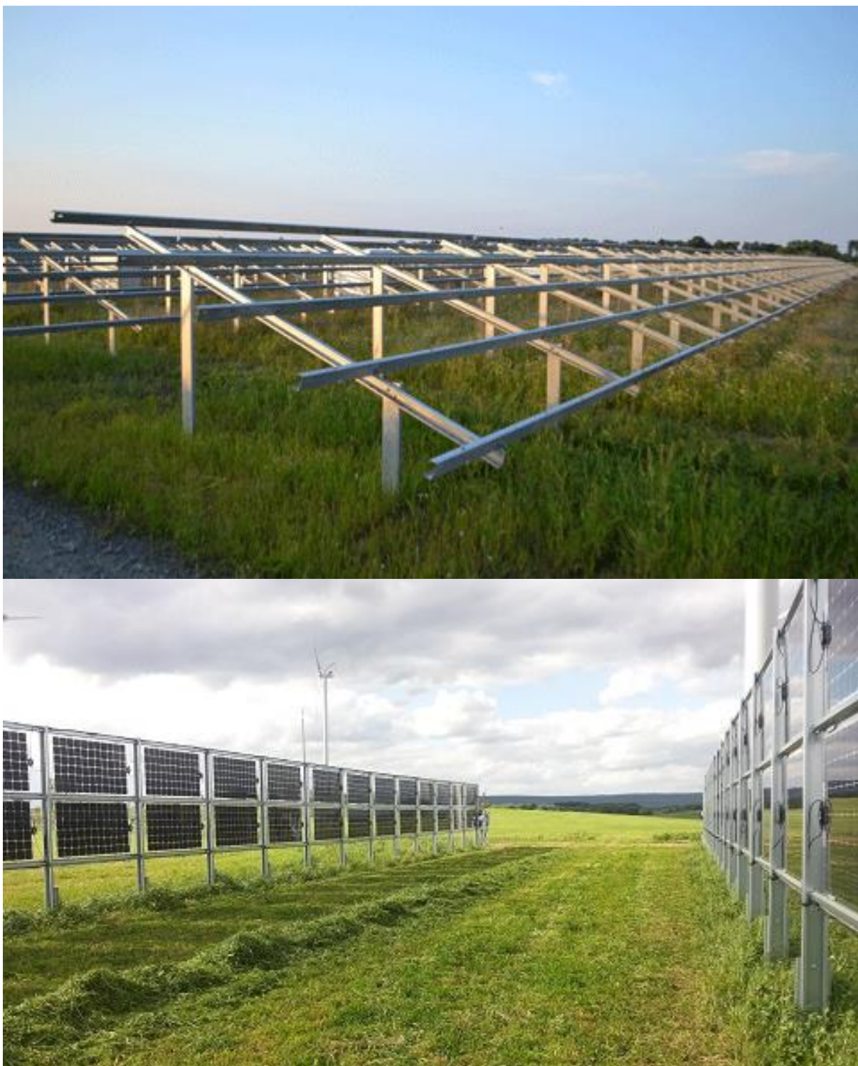
Fot. 2. Stalowa konstrukcja gotowa do montażu paneli fotowoltaicznych. Zdjęcie www.projekt-solartechnik.pl .
