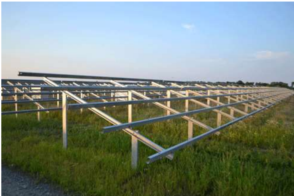
Fot. 2. Stalowa konstrukcja gotowa do montażu paneli fotowoltaicznych. Zdjęcie www.projekt-solarteknik.pl .
