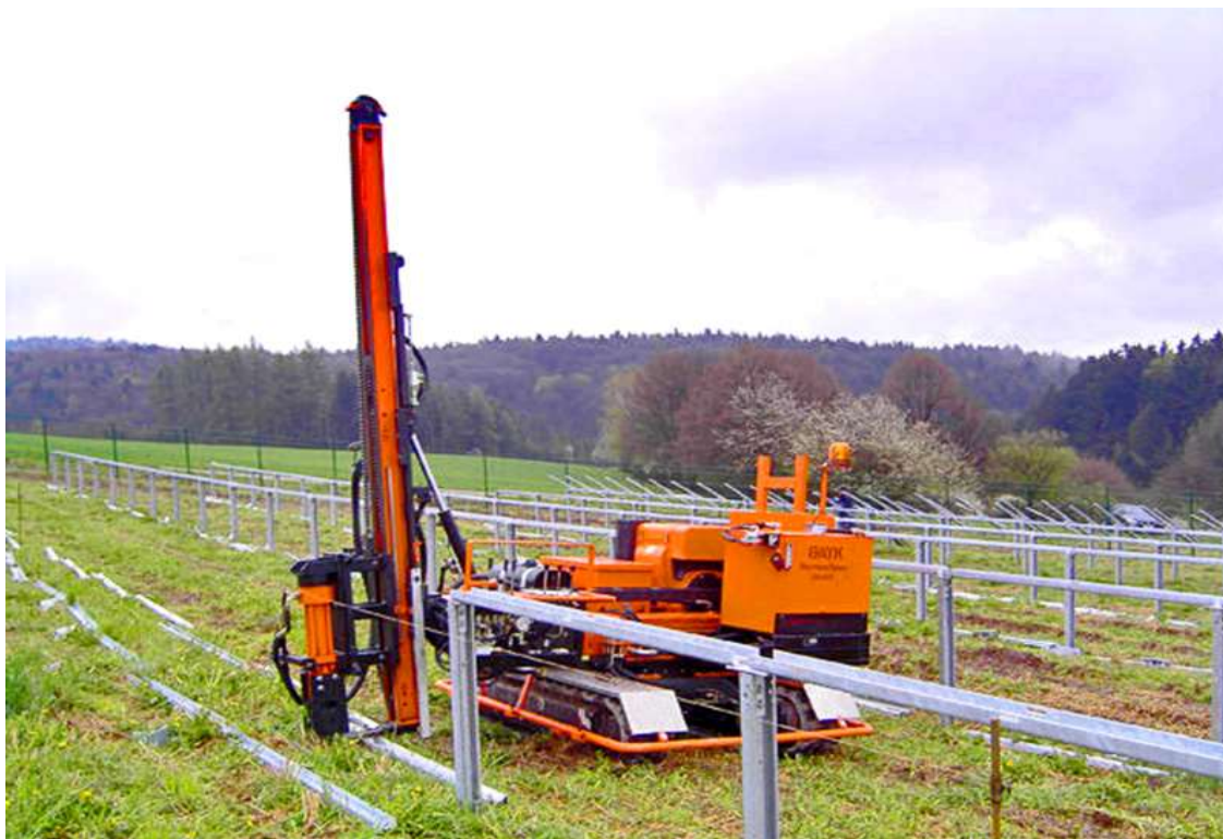
Fot. 1. Maszyna wciskająca konstrukcje stalowe w grunt. Zdjęcie www.projekt-solarteknik.pl .
