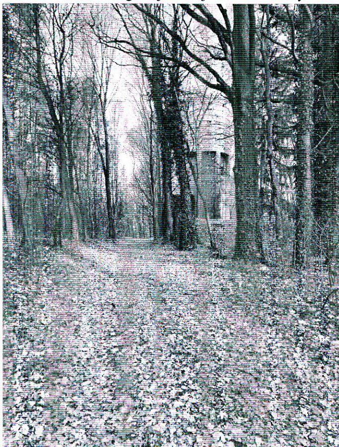
Fot. 5. Widok drogi dojazdowej do wieży ciśnień na terenie „Bażanciarni”.
