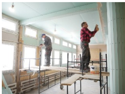
Budowa żłobka przy ul. Łokietka.
